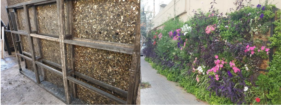
Ecoboards utilizados para hacer muros verdes verticales (Foto: Ziad Abichaker)
